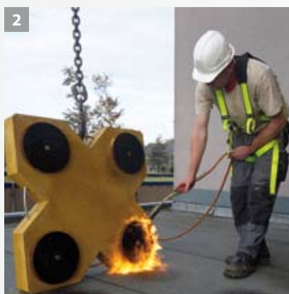
2 Verwarmen van de bitumen plakzegels
